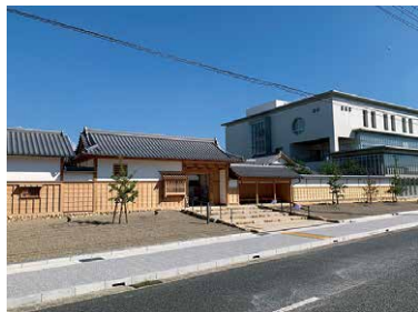
兵庫津ミュージアム 外観
